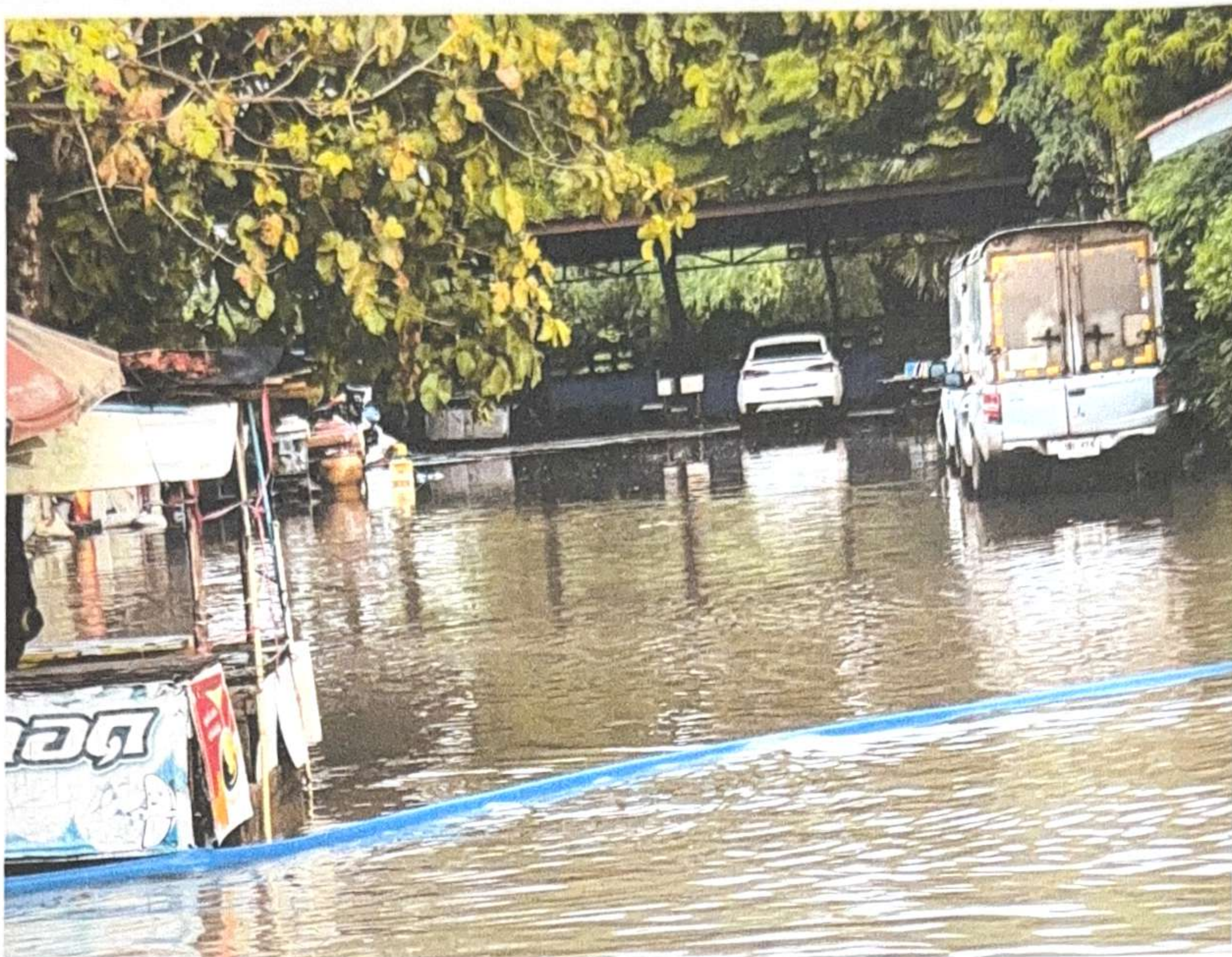
ภาพถ่ายน้ำท่วม ถนนถีนานนท์ (ทางหลวงหมายเลข ๒๑๓)
