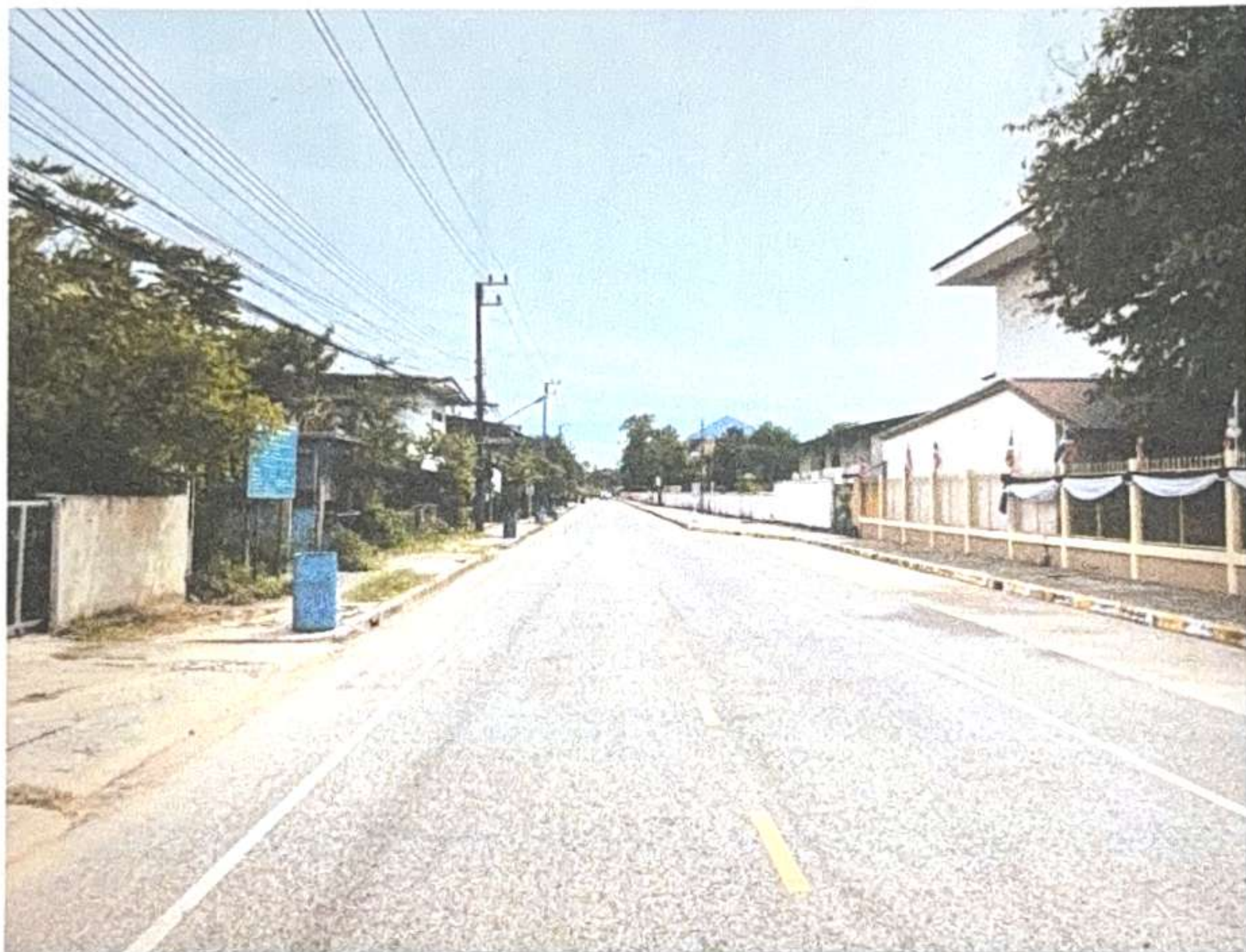
ภาพถ่ายจุดสิ้นสุดโครงการก่อสร้างระบบระบายน้ำถนนศรีสมเด็จ สายทาง กส-ถ-๐๕๑-๐๐๔ ความยาว ๗๓๙ เมตร พร้อม ติดตั้งโคมไฟถนนชนิดปรับความสูงด้วยเฟืองสะพานพร้อมโคมไฟถนนแอลอีดีพลังงานแสงอาทิตย์ จำนวน ๑๔ ชุด ถนนศรีสมเด็จ บ้านสีแยก หมู่ที่ ๔ ตำบลสมเด็จ อำเภอสมเด็จ จังหวัดกาฬสินธุ์ พิกัดโครงการ จุดสิ้นสุด N ๑๖.๗๐๘๙๘๕ E ๑๐๓.๗๔๕๒๑๖
