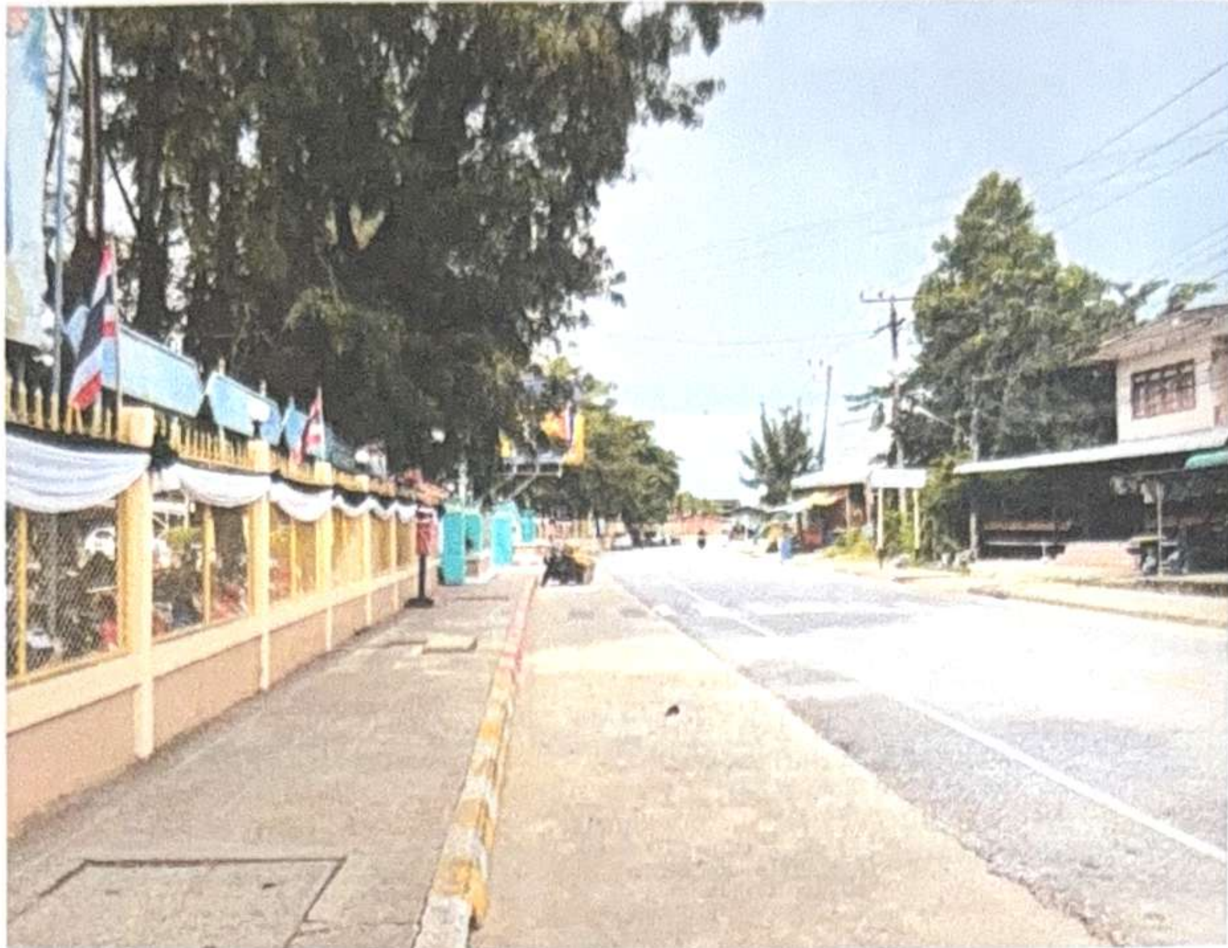
ภาพถ่ายจุดเริ่มต้นโครงการก่อสร้างระบบระบายน้ำถนนศรีสมเด็จ สายทาง กส-ถ-๐๕๑-๐๐๔ ความยาว ๗๓๙ เมตร พร้อม ติดตั้งโคมไฟถนนชนิดปรับความสูงด้วยเฟืองสะพานพร้อมโคมไฟถนนแอลอีดีพลังงานแสงอาทิตย์ จำนวน ๑๔ ชุด ถนนศรีสมเด็จ บ้านสีแยก หมู่ที่ ๔ ตำบลสมเด็จ อำเภอสมเด็จ จังหวัดกาฬสินธุ์ พิกัดโครงการ จุดเริ่มต้น N ๑๖.๗๐๘๕๔๖ E ๑๐๓.๗๕๐๗๐๙
