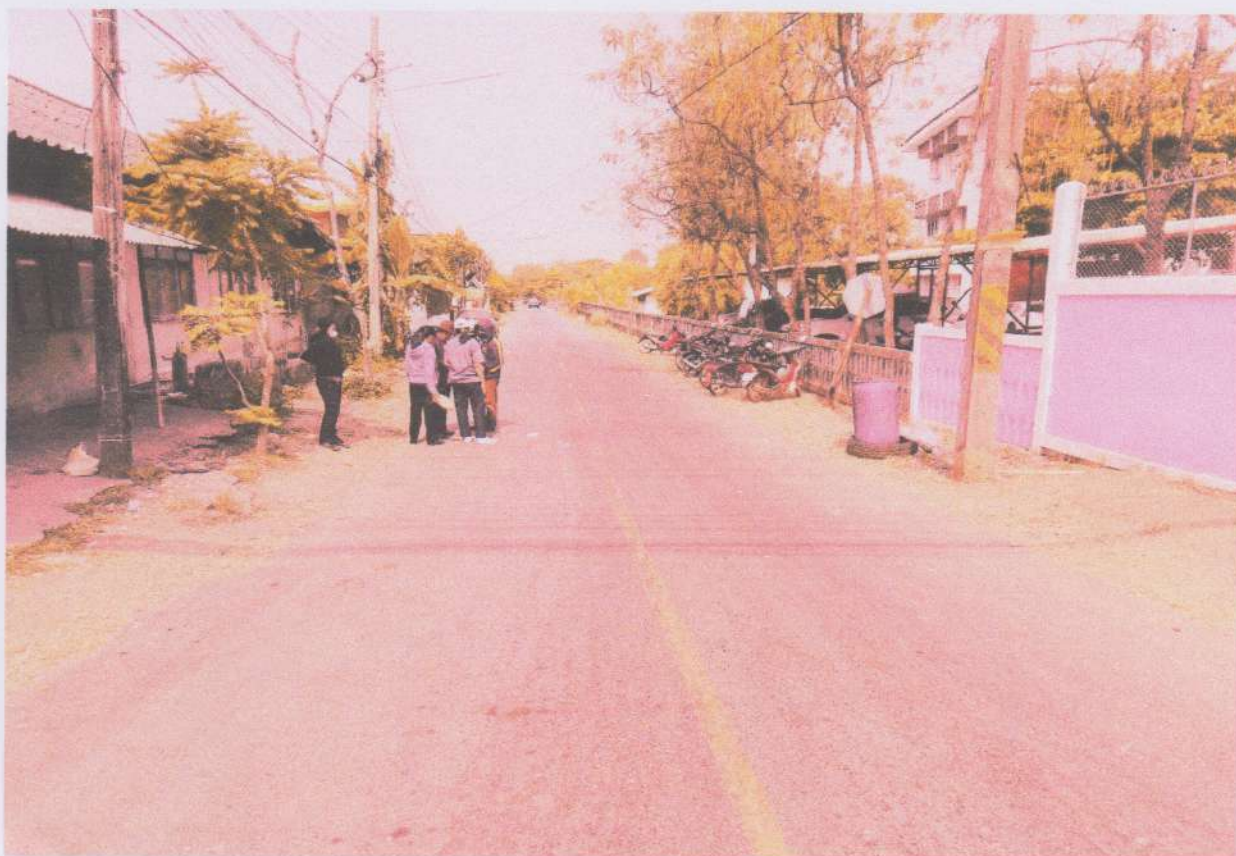
ภาพถ่ายจุดเริ่มต้นโครงการก่อสร้างระบบระบายน้ำ ถนนตริงวารี (กส.ถ.51-005) พิกัดโครงการ N 16.422333 , E 103.445820
